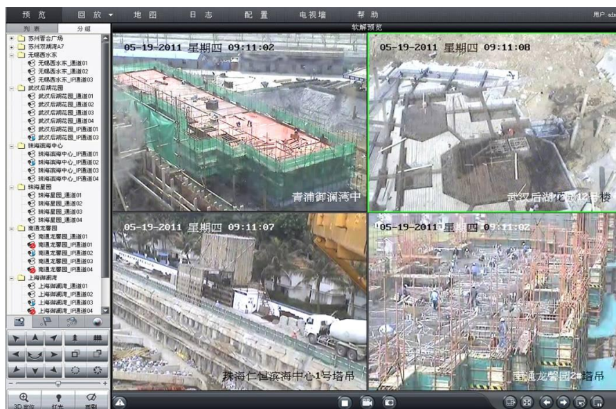
图 5 龙信学院施工现场直播教室
