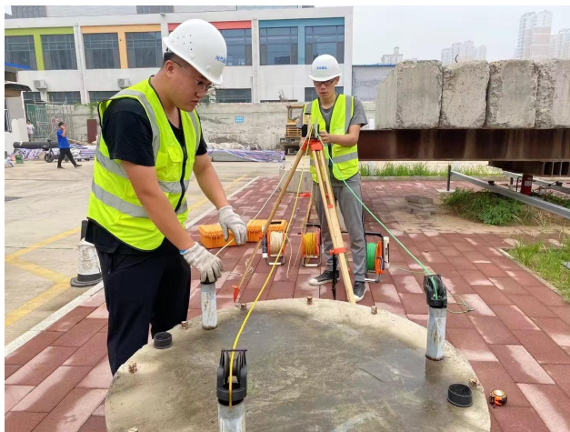
图 3-4 桩基检测
