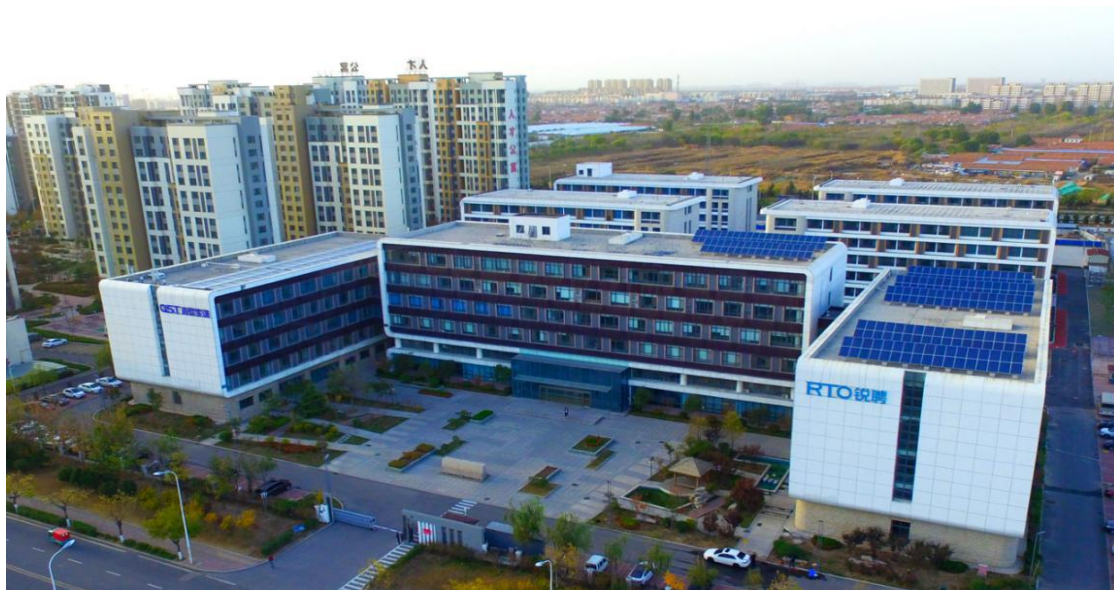
图1 QST 青软集团青岛总部实训基地
