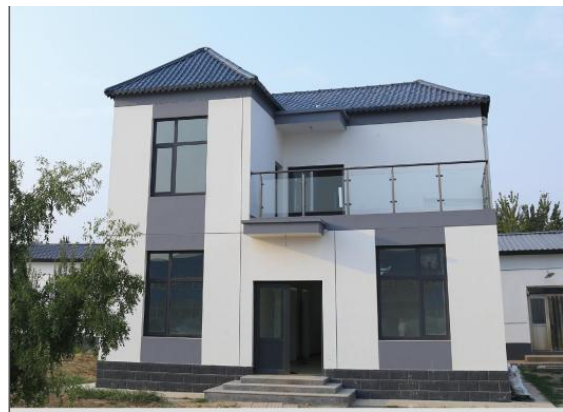
LZPC 装配式建筑
