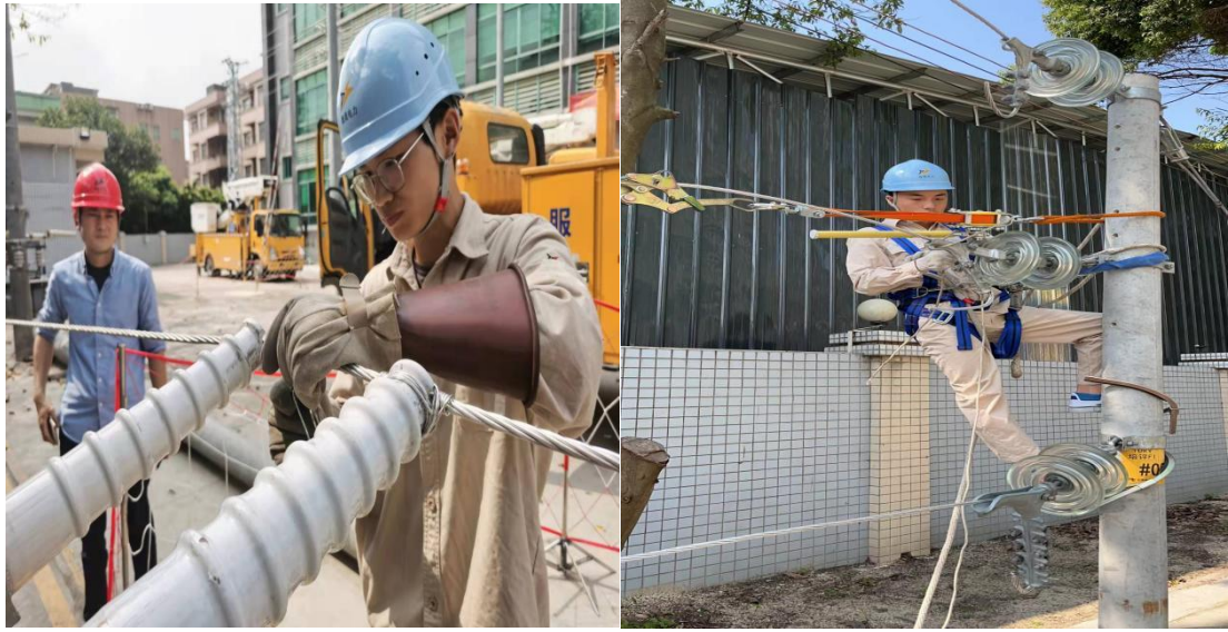
图 5 学员参加配电作业技能培训
