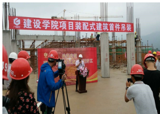
图 26 新校区宿舍装配式项目首件吊装
