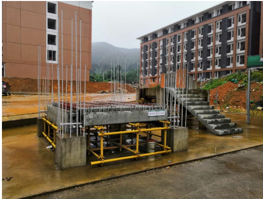
图 28 装配叠合楼板、叠合梁、楼梯安装样板
