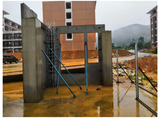
图 29 装配式墙板柱安装样板
