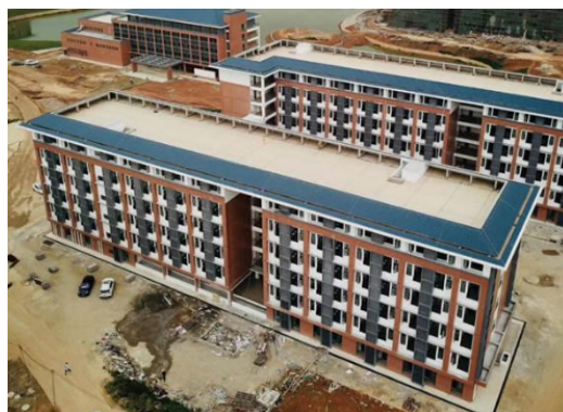
图 27 项目主体结构完工
