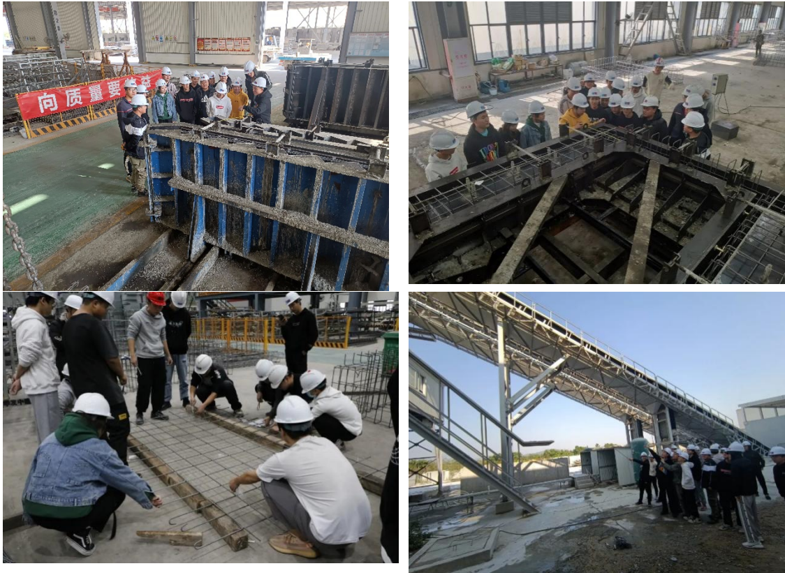
图 32 建工现代学徒制双导师现场集中教学
