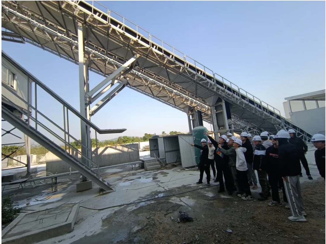
图8 建工现代学徒制双导师现场集中教学
