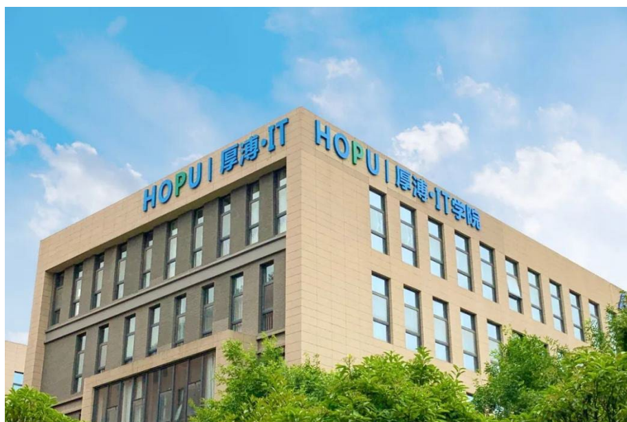
位于武汉的软件新城厚溥大楼
