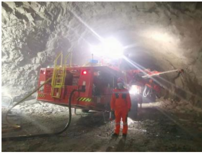
图一 机械化隧道施工
