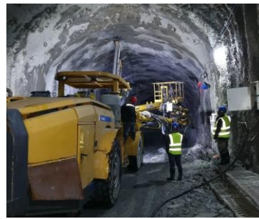
图二 凿岩台车施工现场
