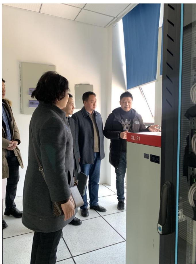
图 1 通信专业实训室网管中心
