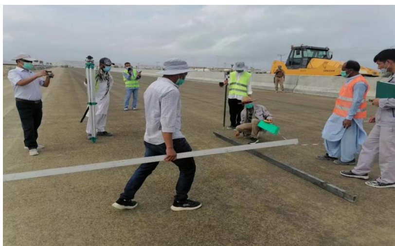
图 5-13 中巴员工在阳光道桥-巴瓜达尔东湾快速路项目现场
