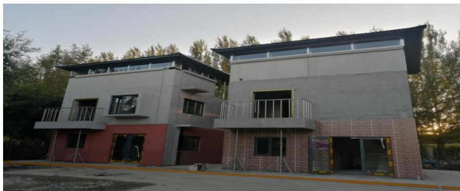
案例 18-图 3：装配式建筑工法楼
