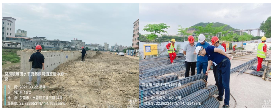
图 2-8 吴彦参与雁田水干流防洪河道整治项目
