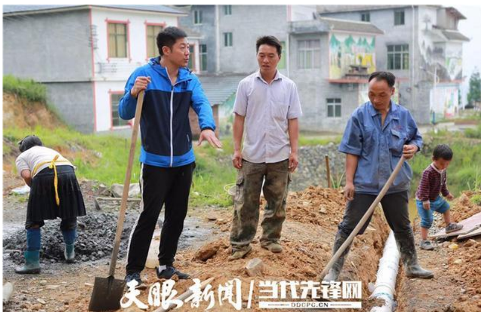
图 6-8 陈瑜同志在荔波县大土村帮助村民铺设管道
